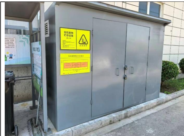
危险废物贮存场所外部
